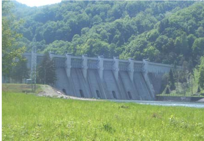
Fig. 2. Rożnów dam on Dunajec River.
