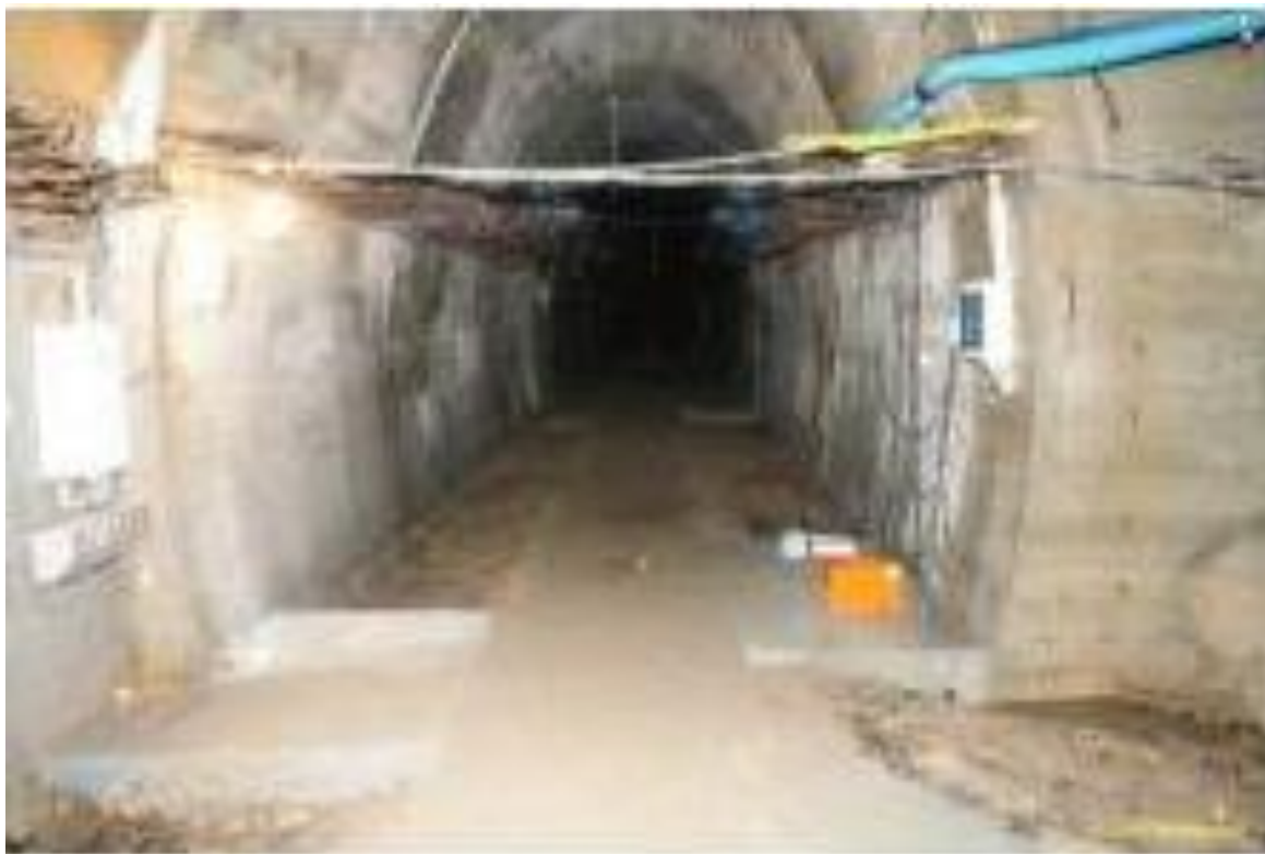
Fig. 2. Basement in the Książ Castle.
